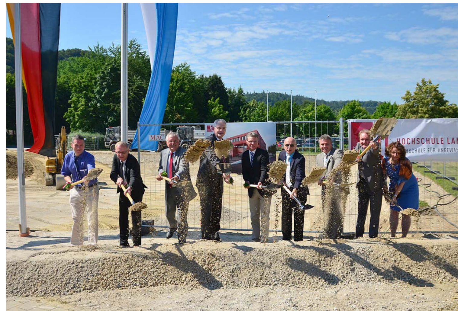
Mit dem obligatorischen Spatenstich im Juli begannen die langersehnten Bauarbeiten des neuen Büro- und Hörsaalgebäudes
