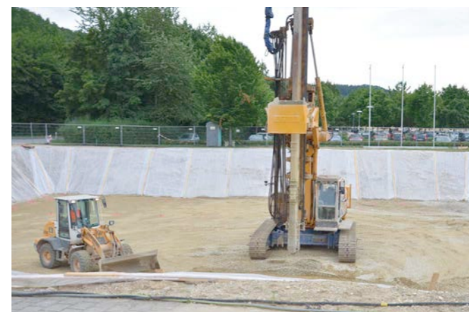
August: Die ersten Großgeräte bereiten den Untergrund für den Neubau vor
