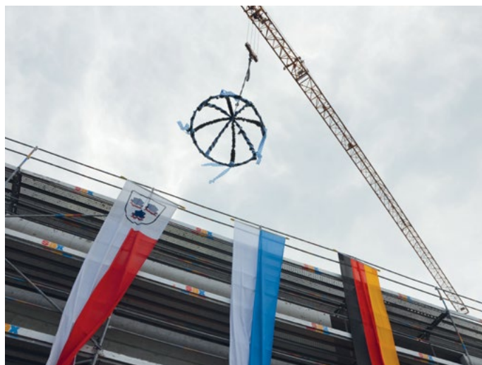
Im Mai wurde das Richtfest für das neue Hörsaal- und Verwaltungsgebäude am Campus gefeiert.
